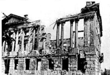
Fot. 2. Zniszczony gmach Biblioteki
